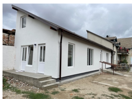
2022 Wir bauen das Blindenhaus auf dem Gelände von Casa Max neu: Dorel untersucht schon mal die Baustelle.
