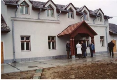
Aufbau eines Werkstatthauses in Nucet.
