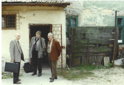
Das Gebäude 1998 vor seiner Renovierung.
